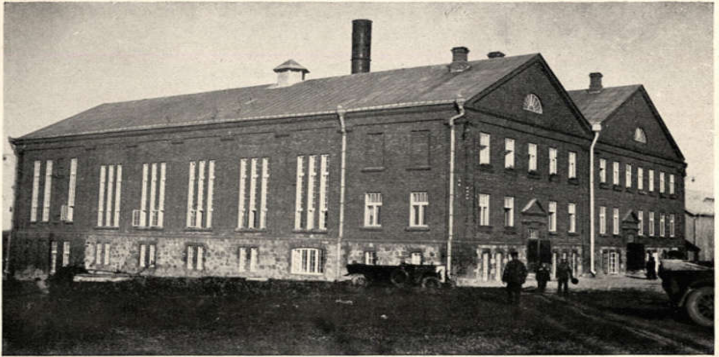
Ulila elektriijaama hoone.
