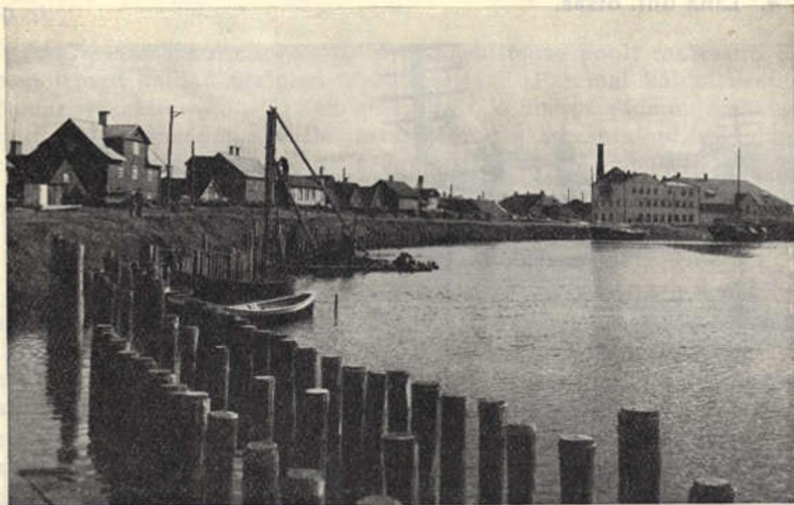
Jõekalda kindlustamine. Consolidation des quais.
