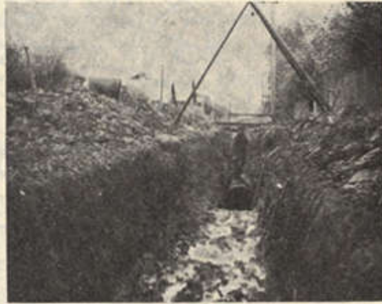
Kanalisatsiooni ehitamine Vaba tänaval.
