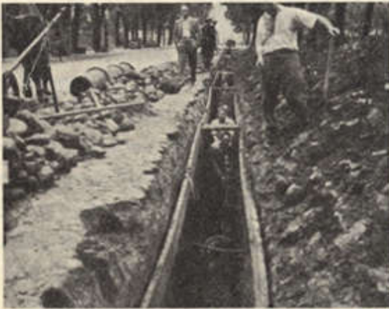
Kanalisatsiooni ehitamine J. Kuperjanovi tänaval.
