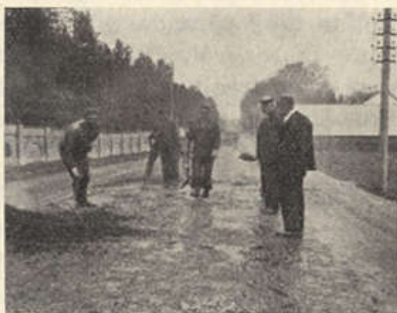
Bituumendatud makadam-teeosa parandamine Narva maanteel.
