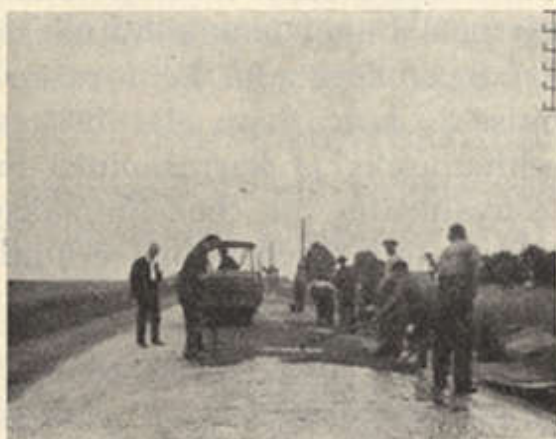
Asfaltbetoon-teeosa ehitamine Võru maanteel.
